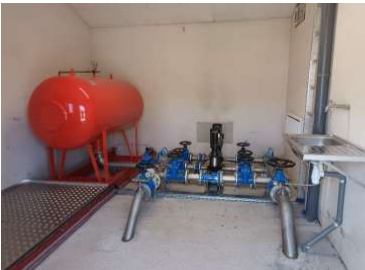
La Station réhabilitée Coût : 33 745.84 €
